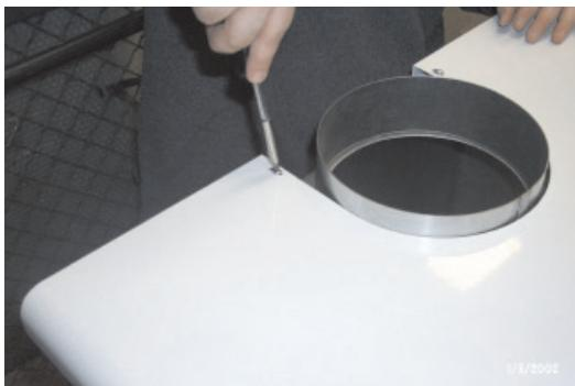
Afb. 3 - Draai de 2 zelftappende schroeven los die het deksel van de verwarmingsketel bevestigen.
