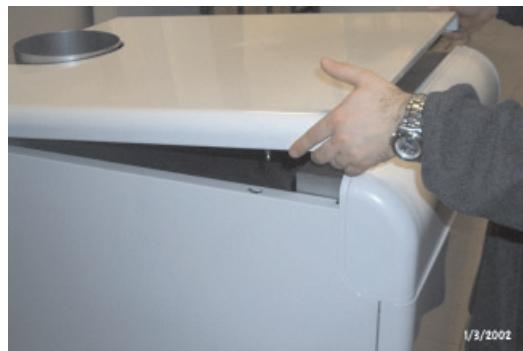
Afb. 4 - Hef ze met een druk van beneden naar boven op en verwijder het deksel dat door de zijpanelen van de verwarmingsketel met klikbevestigingen wordt vastgehouden.
